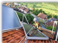
Abbildung 28: Beseitigung von Modulen im Feuerwehreinsatz
